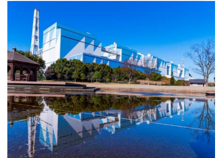
碧南火力発電所
