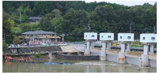
左岸の水漏れ箇所の応急対策工事が完了し、左端の堰柱周辺の根固めを行う本復旧工事を開始しました。工期は、2年間で予定しています。
