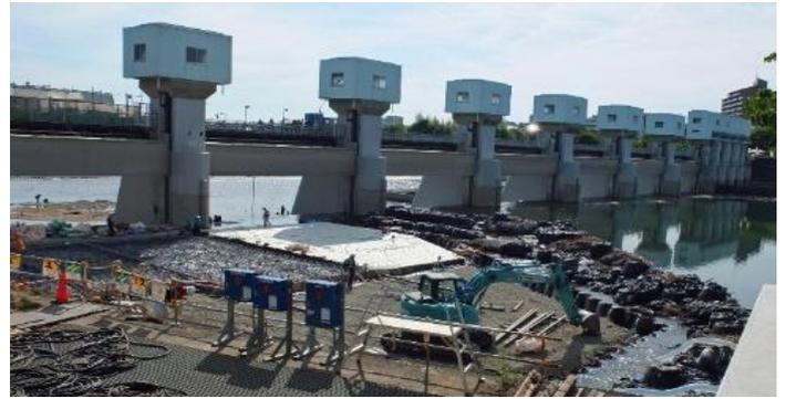
左岸：漏水の流入箇所への応急対策工事。
