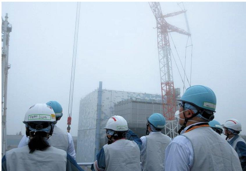
中央は、原子炉2号機です。1号機の水素爆発により2号機建屋の壁が破損したため水素爆発に至りませんでした。建屋を解体せずに壁面構台を建設して燃料を取り出す工法を計画。東京電力は、福島原発の全原子炉を廃炉にすることを決定。約40年かけて完了させることを目標に作業を進行中。
