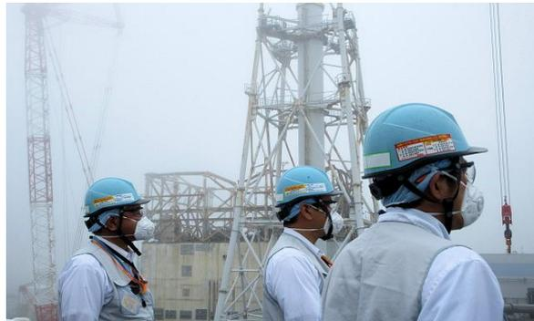
原子炉1号機です。津波で電源喪失により水素爆発が発生し建物が破損。今後の燃料取り出しに向け、建屋全体を覆う大型カバーを設置し、大型カバーの中で、ガレキ撤去等を行う計画。
